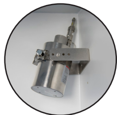
◀ Extincteur automatique à ampoule 79°C (EX100LI)
