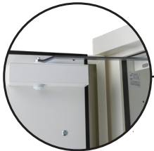
Ferme-porte avec thermofusible
